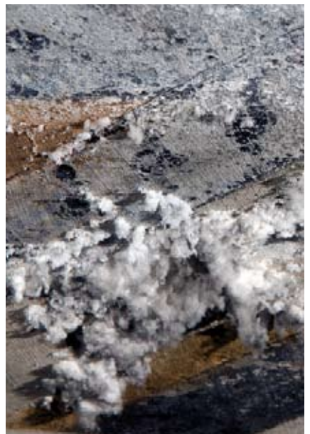
détails d'efflorescence de sels
