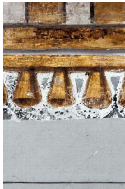
en cours d'enlèvement des couches de chaux
