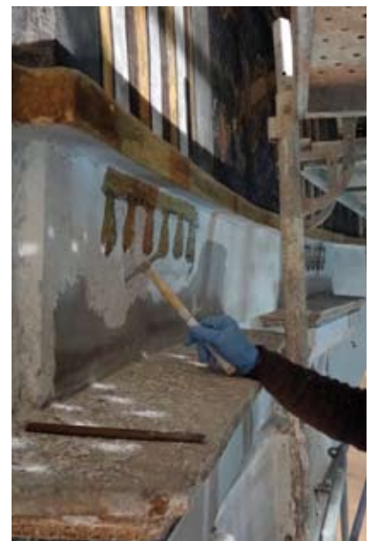
en cours d'enlèvement des couches de chaux
