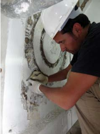
en cours d'enlèvement des couches de chaux
