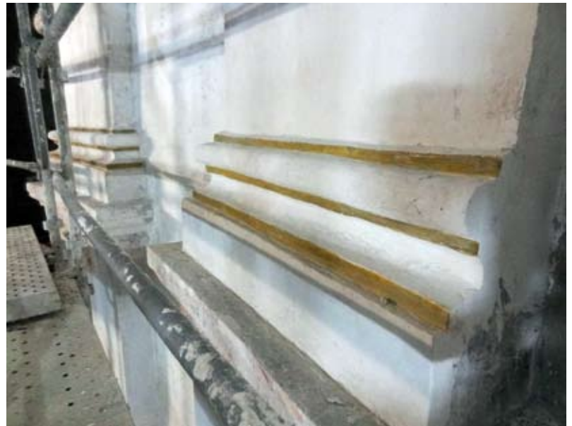
état des bases après la recuperation de la dorure
